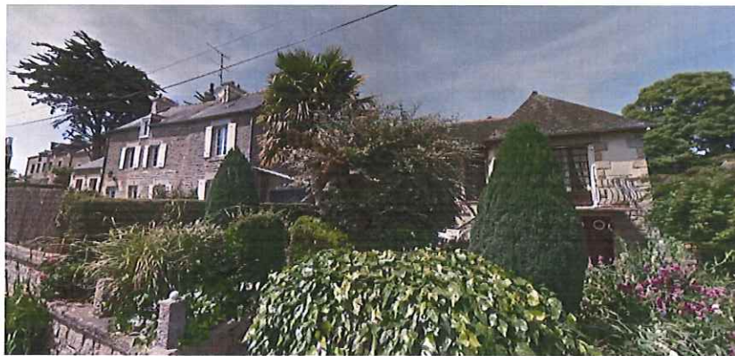
Vue sur les parcelles 299 et 302 rue de Bon Secours
