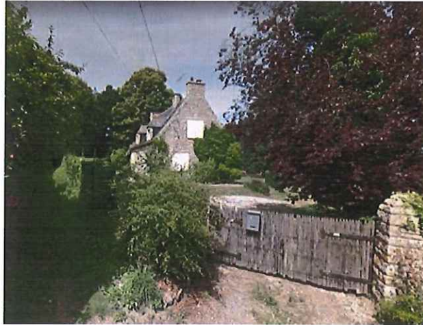
Vue sur la parcelles 176 et 177 - rue de Bon Secours
